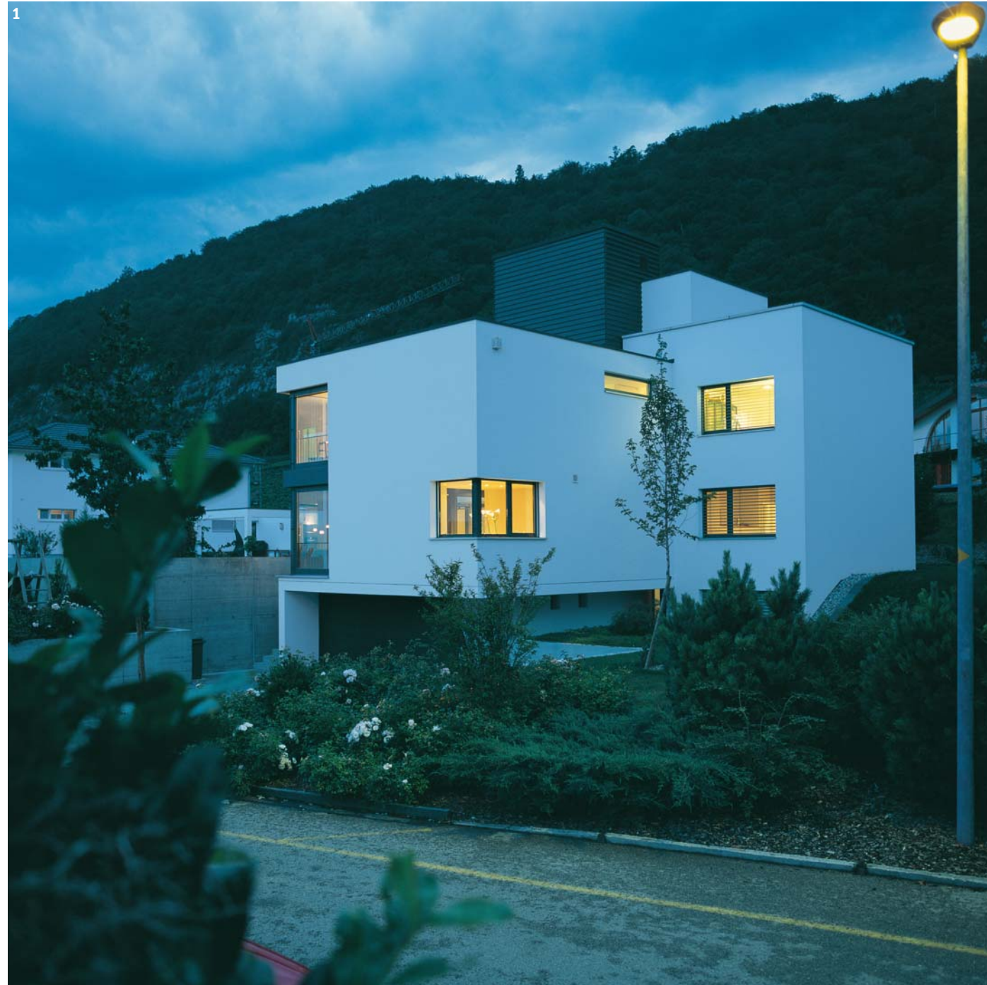
1) Ein Ensemble, das durch sein zentrales Erschließungskonzept und seinen T-förmigen Grundriss besticht. 2) Schwebende Leichtigkeit dank klarer architektonischer Linienführung.
