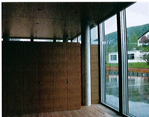
Plafonds et panneaux muraux en chêne de fil pour le personnel administratif.
